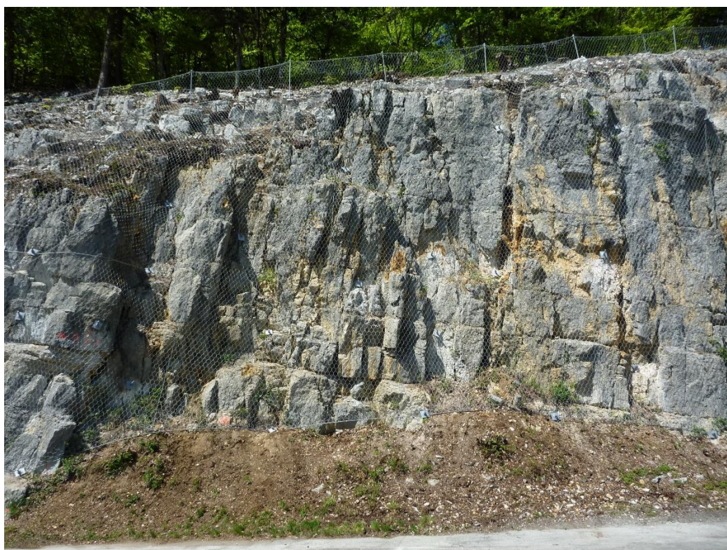
Figure 14 : Treillis métalliques plaqués et mini-barrière sommitale. Ouvrages proposés dans les secteurs Les Murets, Cochâble Sud, Cochâble I et II, Les Recolas.
