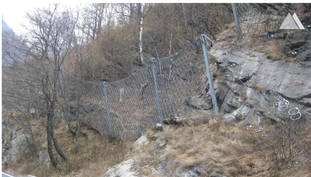
Figure 12 : Filet pare-pierres 250 kJ (type Geobrigg® RXI-025 – Photo www.geobrigg.com ) Ouvrages proposés dans les secteurs Les Murets, Trois-Villes, Cochâble I et II.
