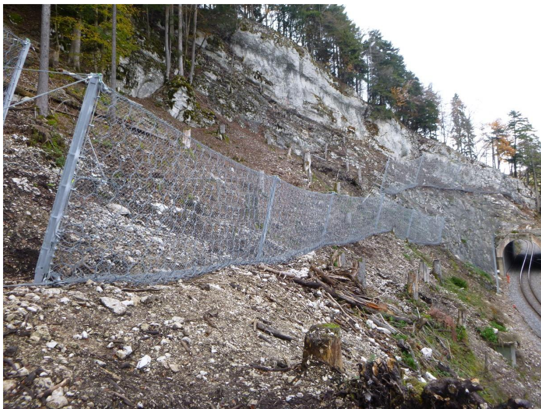
Figure 13 : Filet pare-pierres 500 kJ (type Geobrugg® RXI-025). Ouvrages proposés dans le secteur Cochâble Sud.
