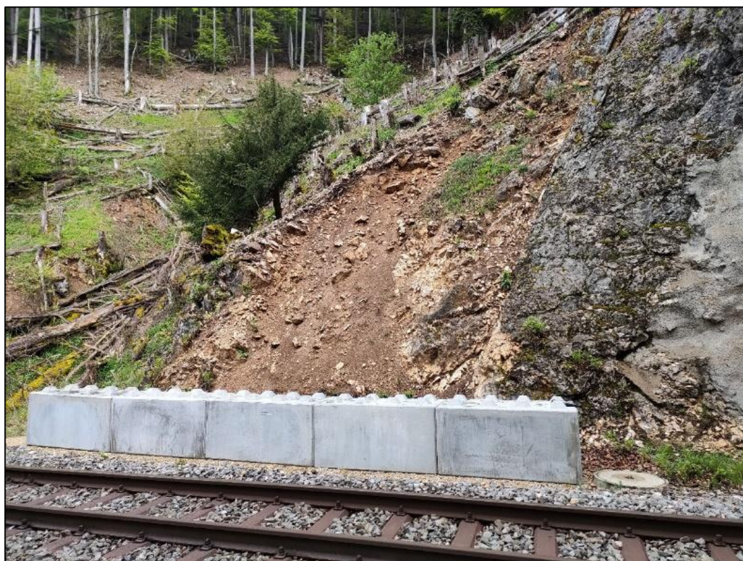
Figure 9 : Photo du talus rocheux au portail Sud du tunnel de Cochâble II.
