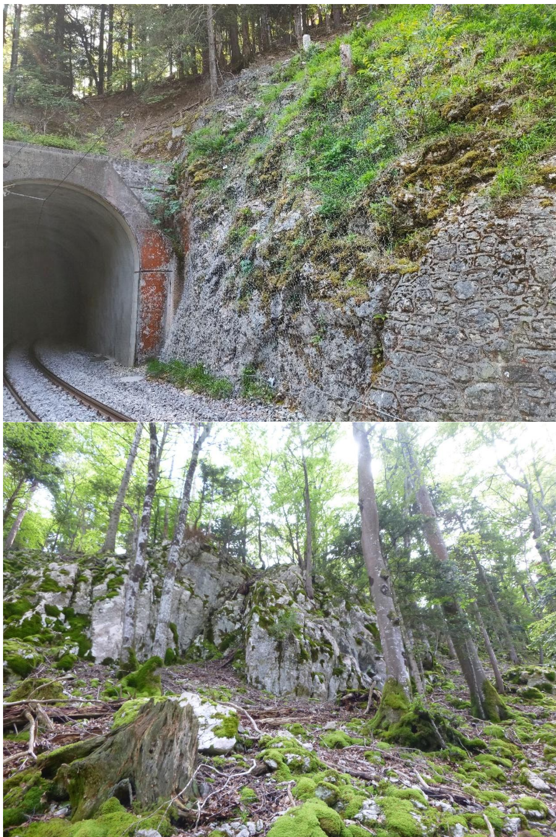
Figure 3 : Photos des parois rocheuses du secteur Les Murets. (Haut) Portail nord du tunnel des Murets. (Bas) Dans le versant surplombant les voies.
