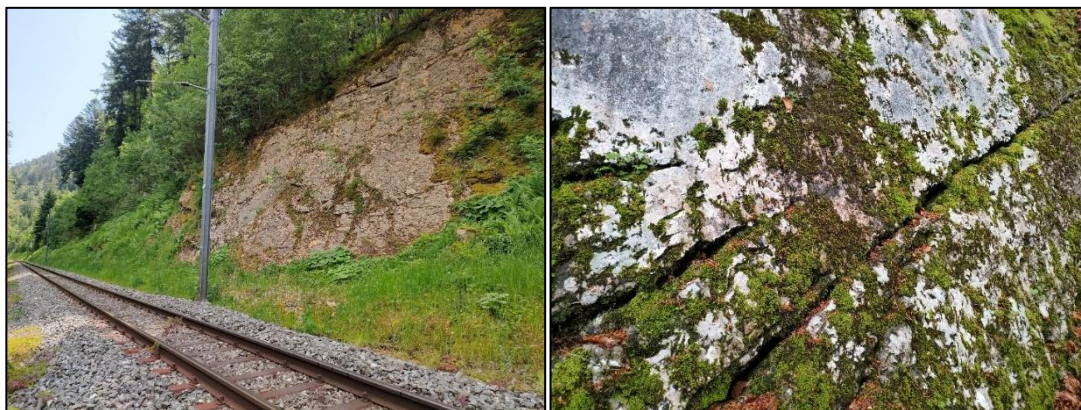
Figure 11 : Photos des parois rocheuses du secteur Les Recolas. (Gauche) Paroi en bordure de voies. (Droite) Fractures persistantes dans les Raisses-Gueissaz.
