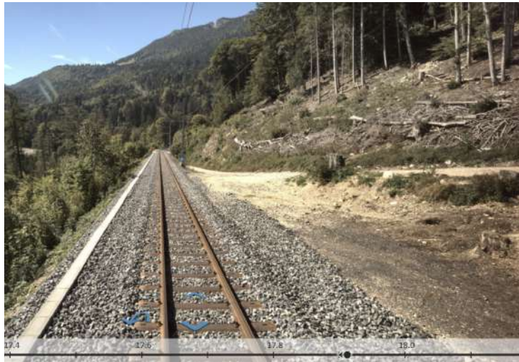
Figure 6-14 : Photo de la planie en bord de voies prévue pour l'enraillement.
