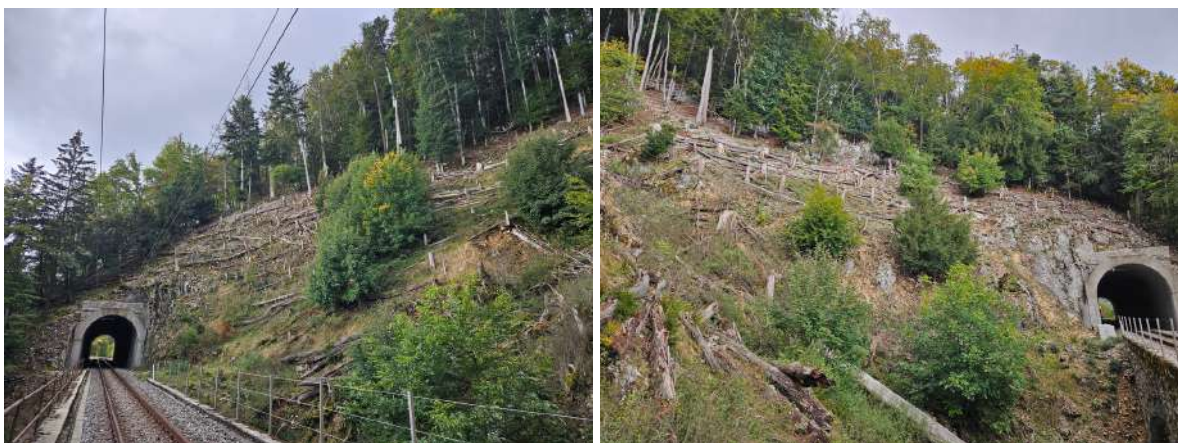
Figure 6-11 : Photos du secteur 4 "Cochâble".
