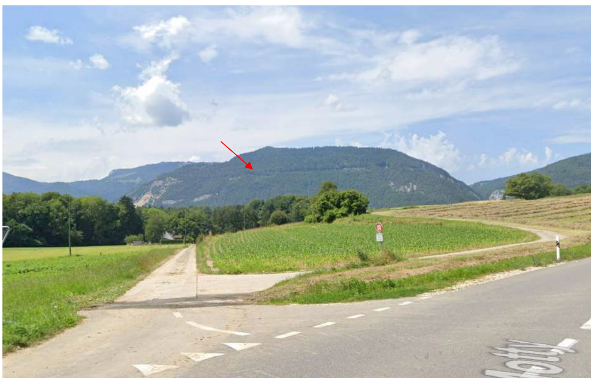
Figure 6-6 : Vue sur la voie de chemin de fer depuis la route de Sainte-Croix entre Essert-sous Champvent et Vuiteboeuf. La ligne ferroviaire est visible par la coupure dans la forêt. La flèche rouge indique l'emplacement approximatif du secteur 3. Source : Google Maps.
