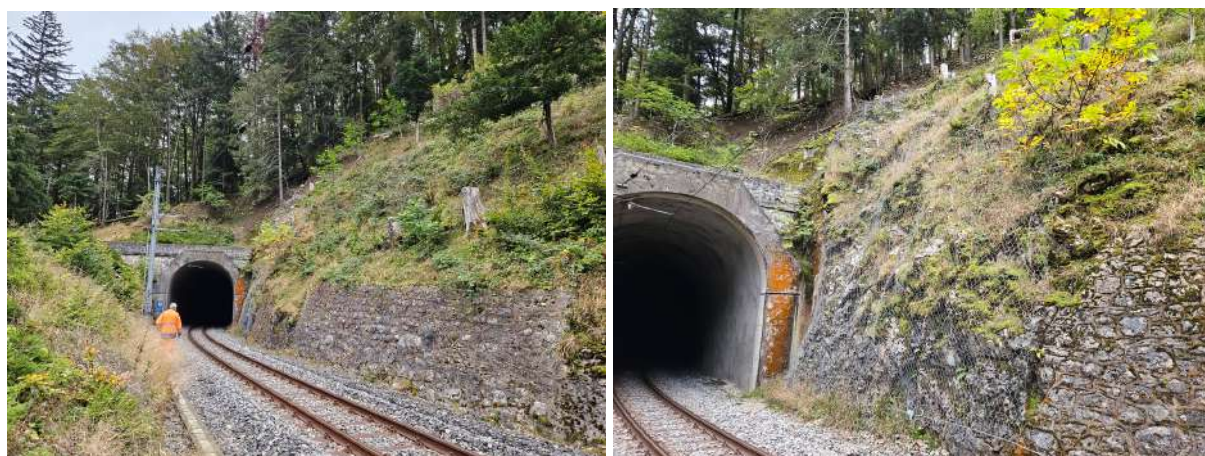
Figure 6-3 : Photos du secteur 1. Le treillis plaqué déjà en place est visible, ainsi que le filet provisoire.
